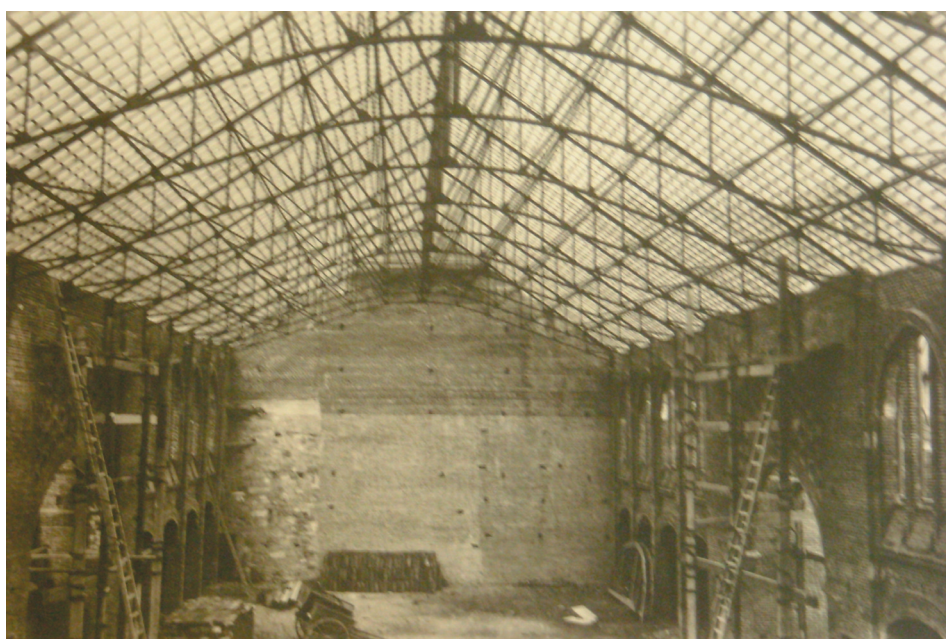
● Obres de remodelació del sostre del Mercat Municipal d'Arenys de Mar (1940). Foto de l'Arxiu Històric Fidel Fita.
