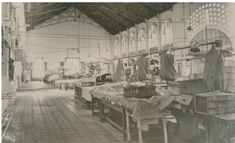
● Vista antiga de l'interior del Mercat Municipal d'Arenys de Mar (Arxiu Històric Fidel Fita).
