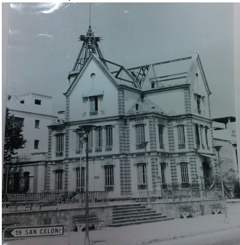
Enderrocament de Can Formosa, l'any 1966.
