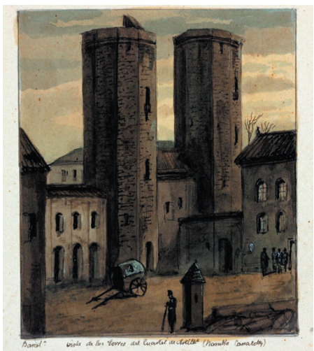
Gravat de la part posterior de l'edifici de la Universitat de Barcelona.
